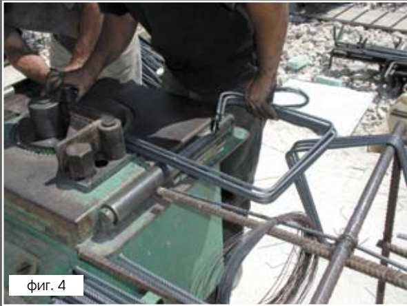
Ръчно изготвяне на стремена.
