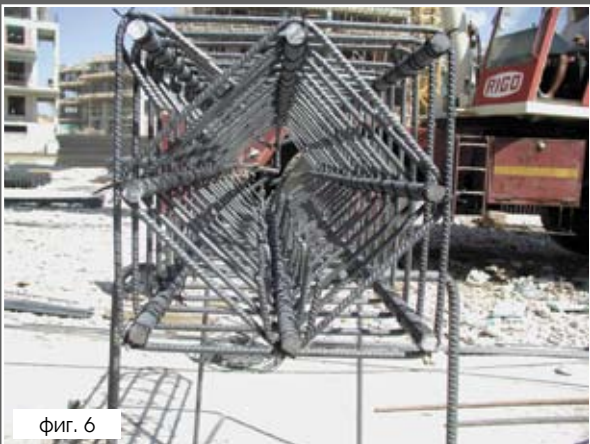
Арматурен пакет за колона, изготвен по традиционния начин
