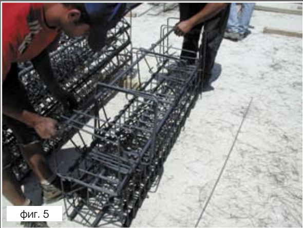
Изготвяне на краен армиращ продукт за колона със свързване на стремената към надлъжните носещи пръти
