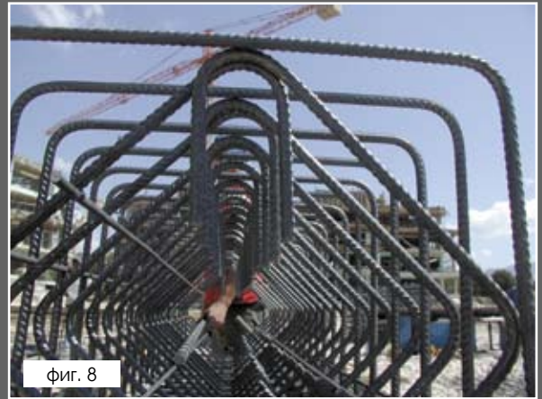
Лесно монтиране на надлъжната армировка към готовия скелет SIDEFOR
